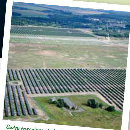
Solarenergiepark in Tutow Freiflächen-Photovoltaik-Anlage
