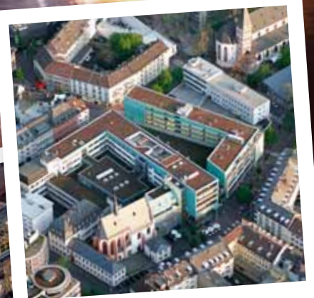
Römerpassage, Mainz Wärme-/Kälteerzeugung aus Grundwasser
